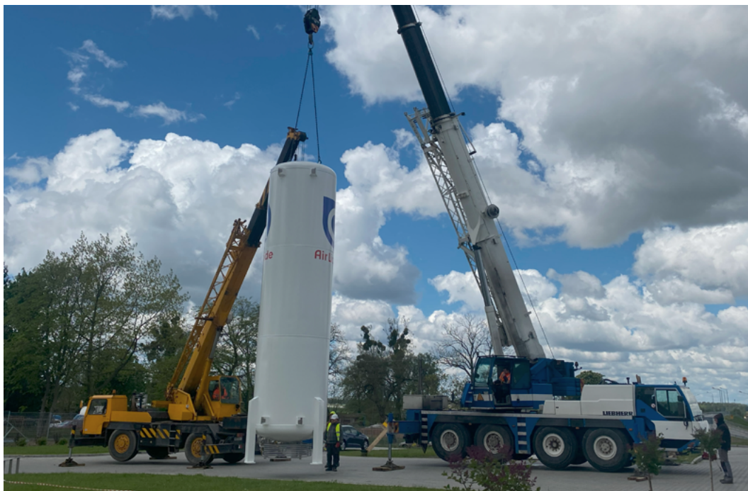
Fot.11. Montaż zbiornika z ciekłym azotem w zakładzie produkcyjnym w Załuskach.
